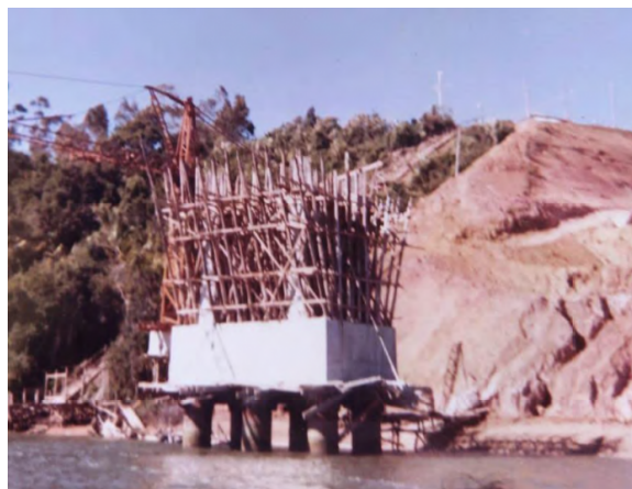
Figura 12: Construção da ponte, 1984.
