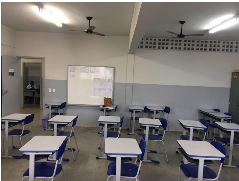
Figura 7: Fotografia parede lateral do corredor da sala 01.
