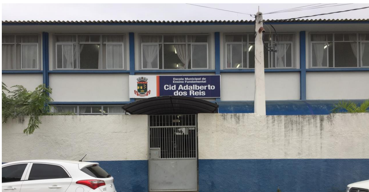
Figura 33: Fotografia da fachada da escola.
