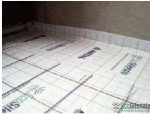
Imagem 5 – Execução de Manta de fibra de poliéster.
