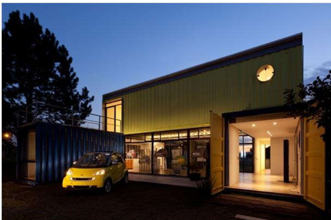
Imagem 17 – Vista Traseira Casa Container Granja Viana
