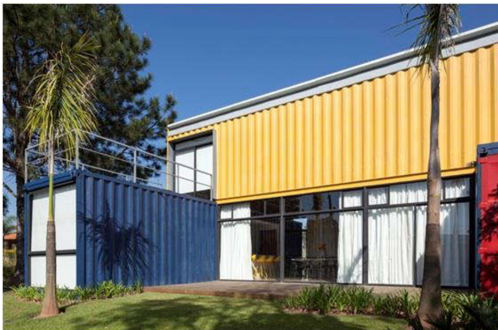
Imagem 16 – Vista Traseira Casa Container Granja Viana
