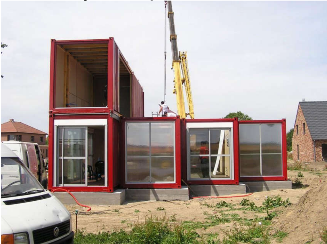
Imagem 28 – Acomodação dos containers na estrutura
