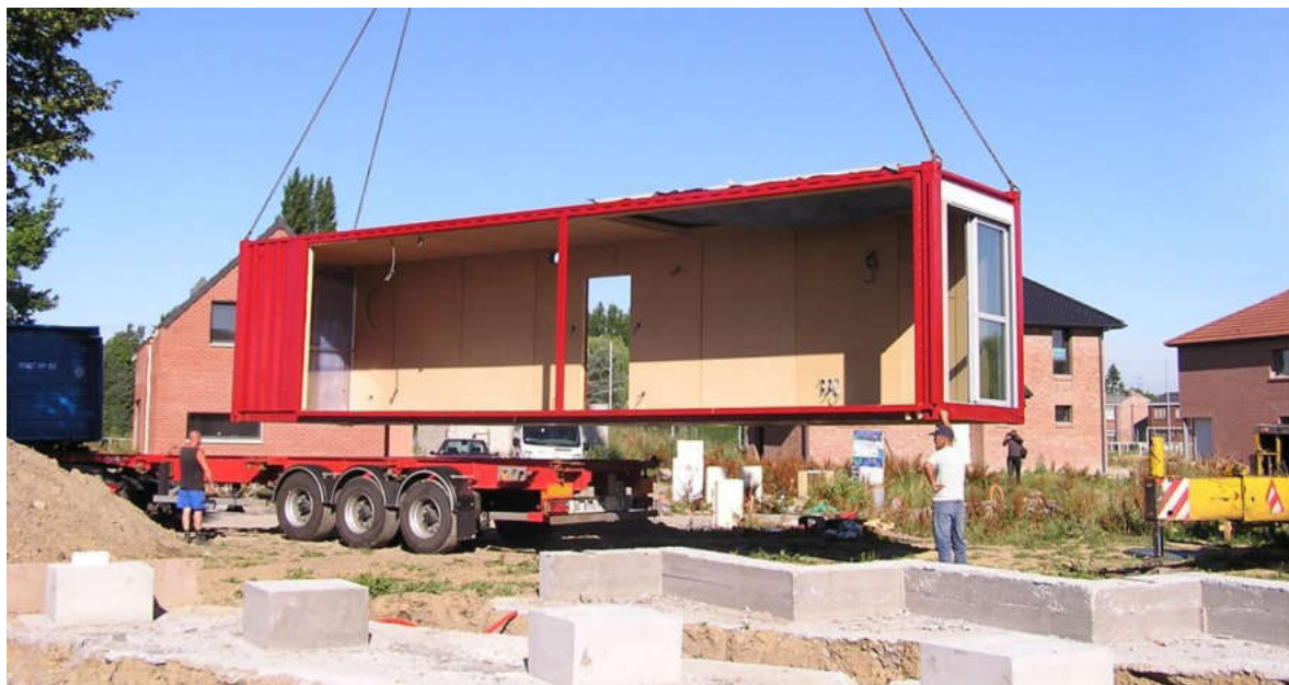
Imagem 26 – Container sendo erguido para acomodação na base
