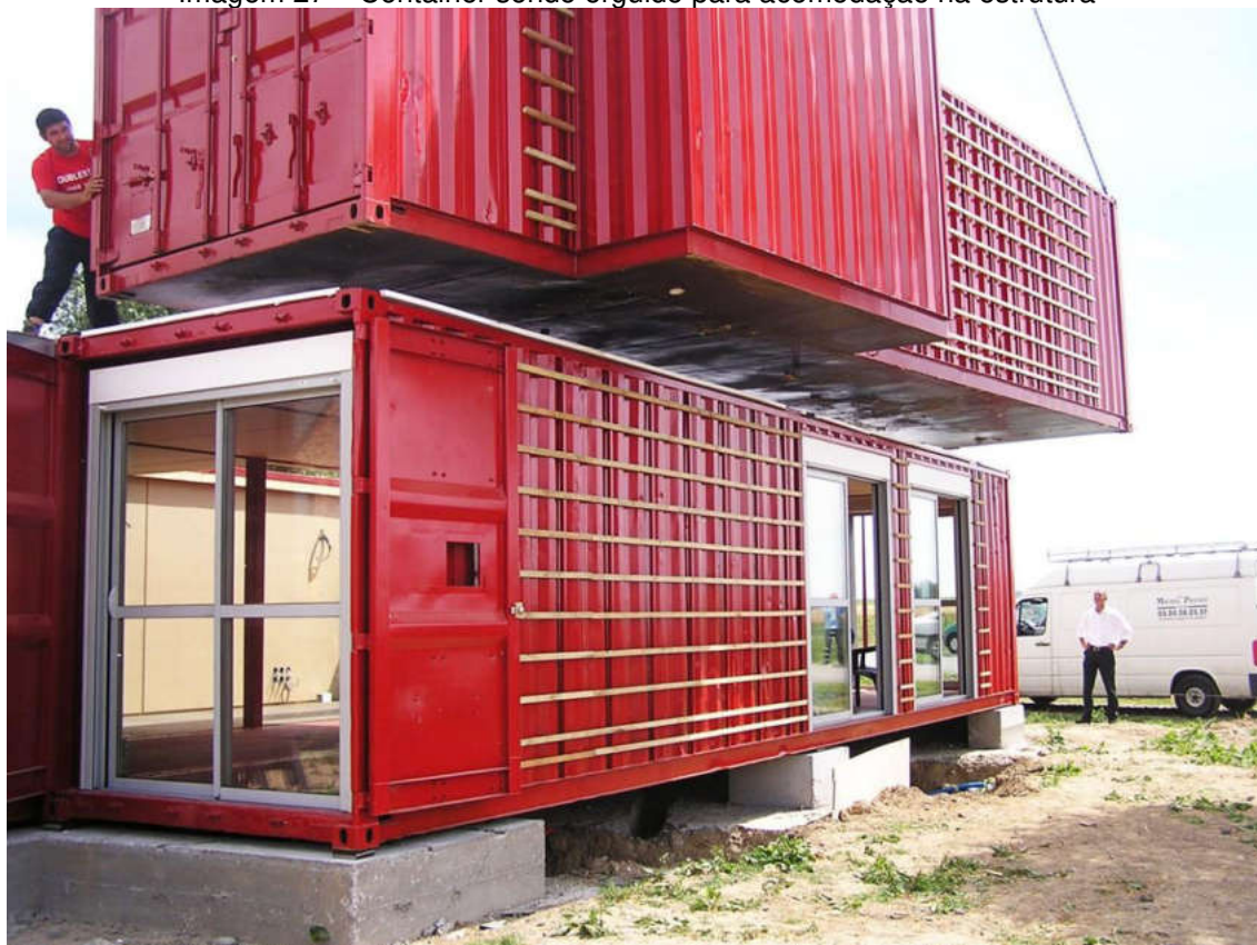
Imagem 27 – Container sendo erguido para acomodação na estrutura
