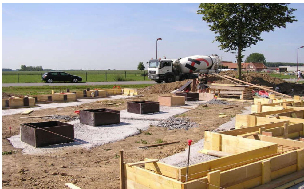
Imagem 25 – Construção da Fundação da Casa Container Lille
