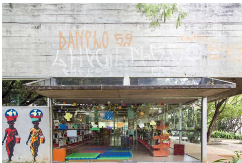
Figura 10: Fachada do CCJ 2
