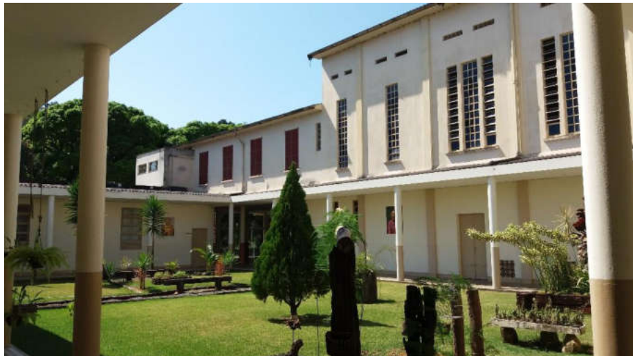
Figura 71: Pátio interno, capela e pilotis
