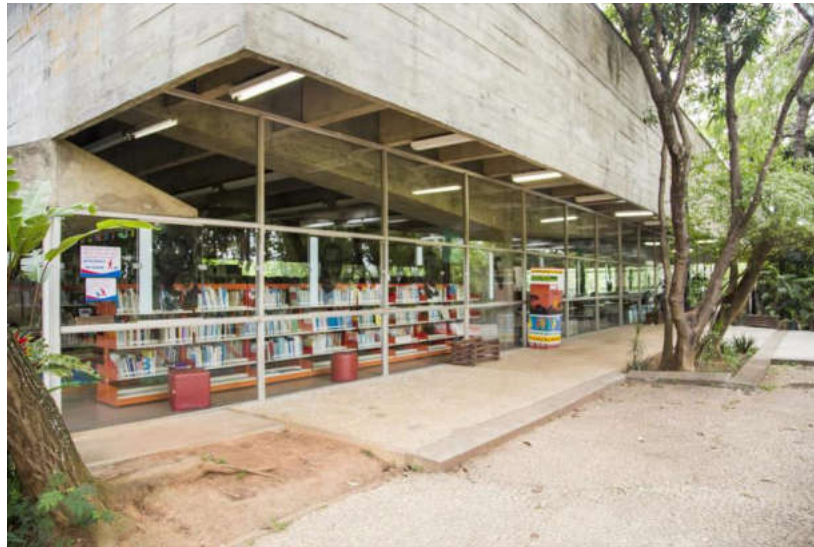
Figura 9: Fachada do CCJ
