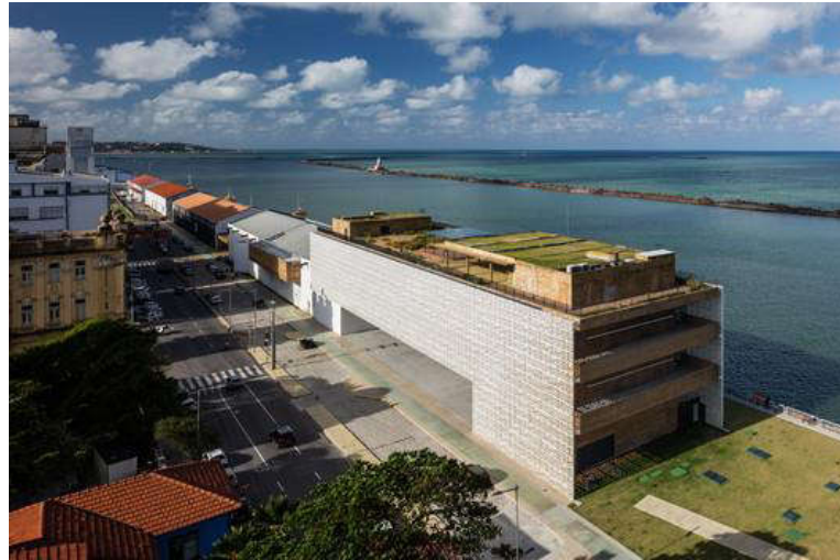
Figura 24: Museu Cais do Sertão vista aérea
