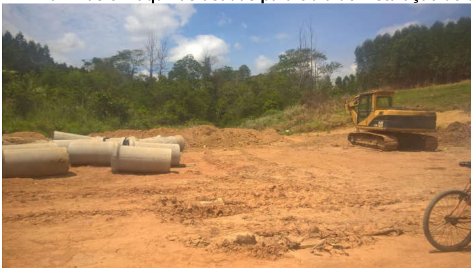
Figura 14: Manilhas e máquinas usadas para obra de instalação de esgoto.
