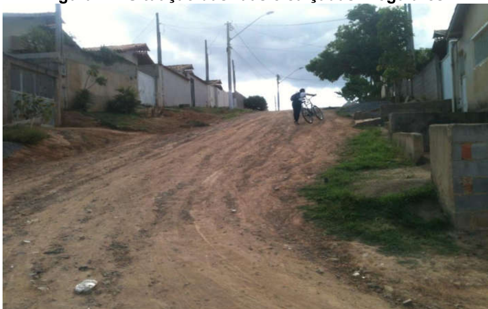
Figura 22: Situação das ruas e calçadas irregulares.
