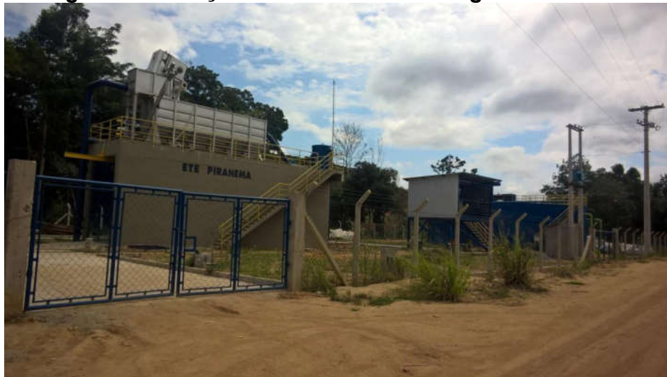
Figura 15: Estação de Tratamento de Esgoto Piranema.
