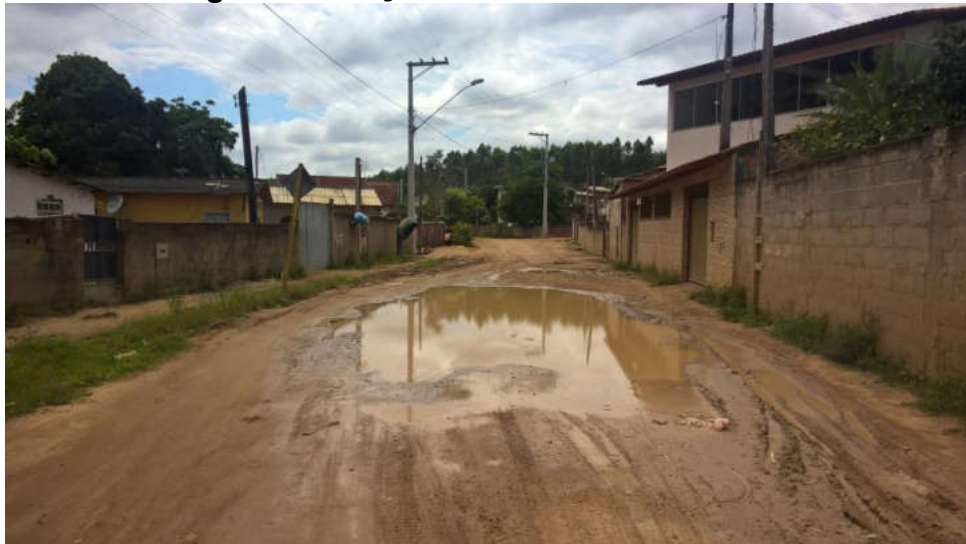
Figura 17: Poça formada devido à chuva.
