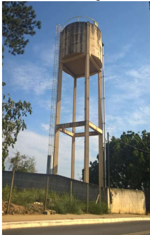
Figura 9: Reservatório de água Bairro Cupido.
